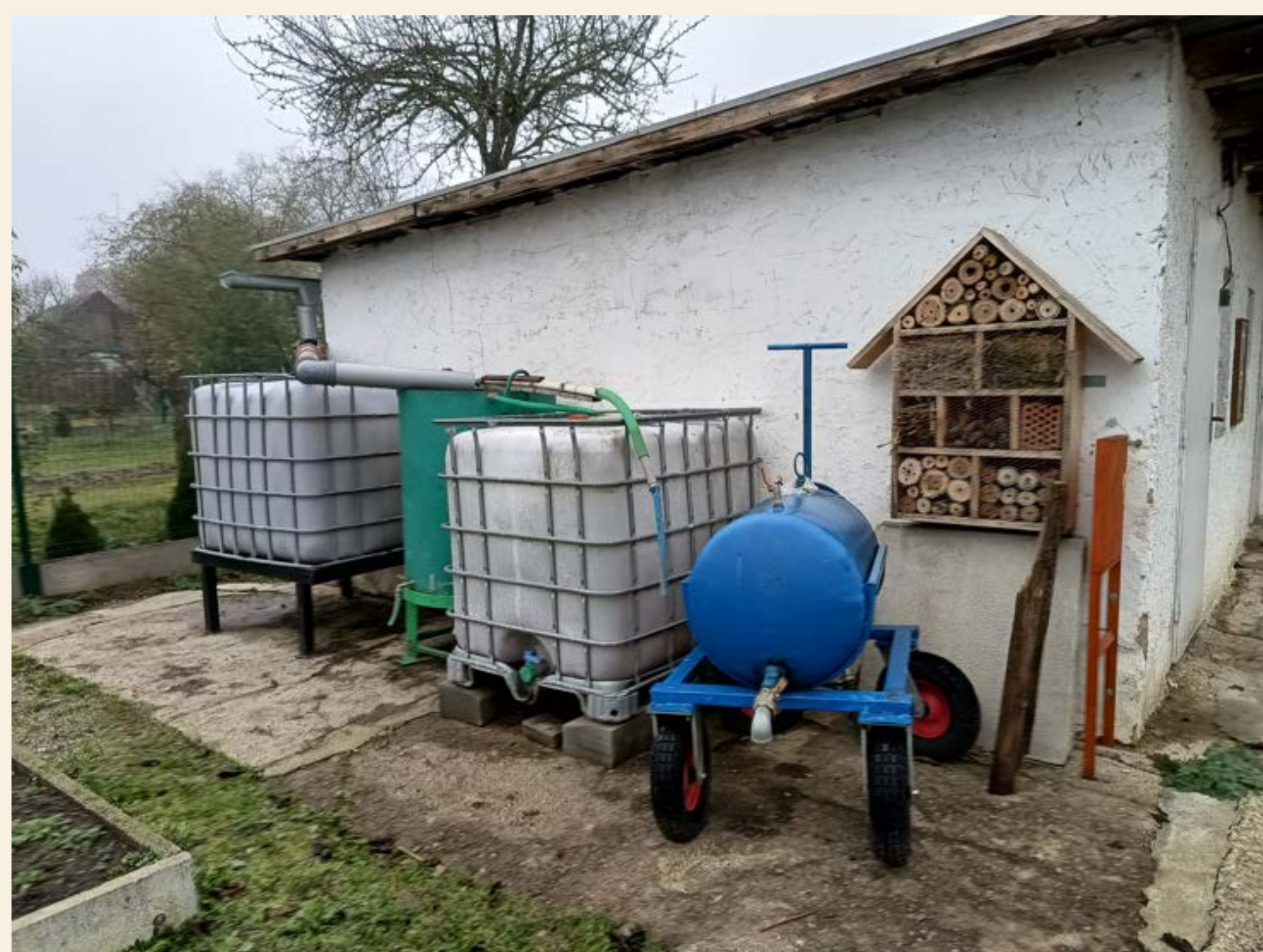
Retenční nádrž Sešovce (foto: archiv CEEV Živica)
